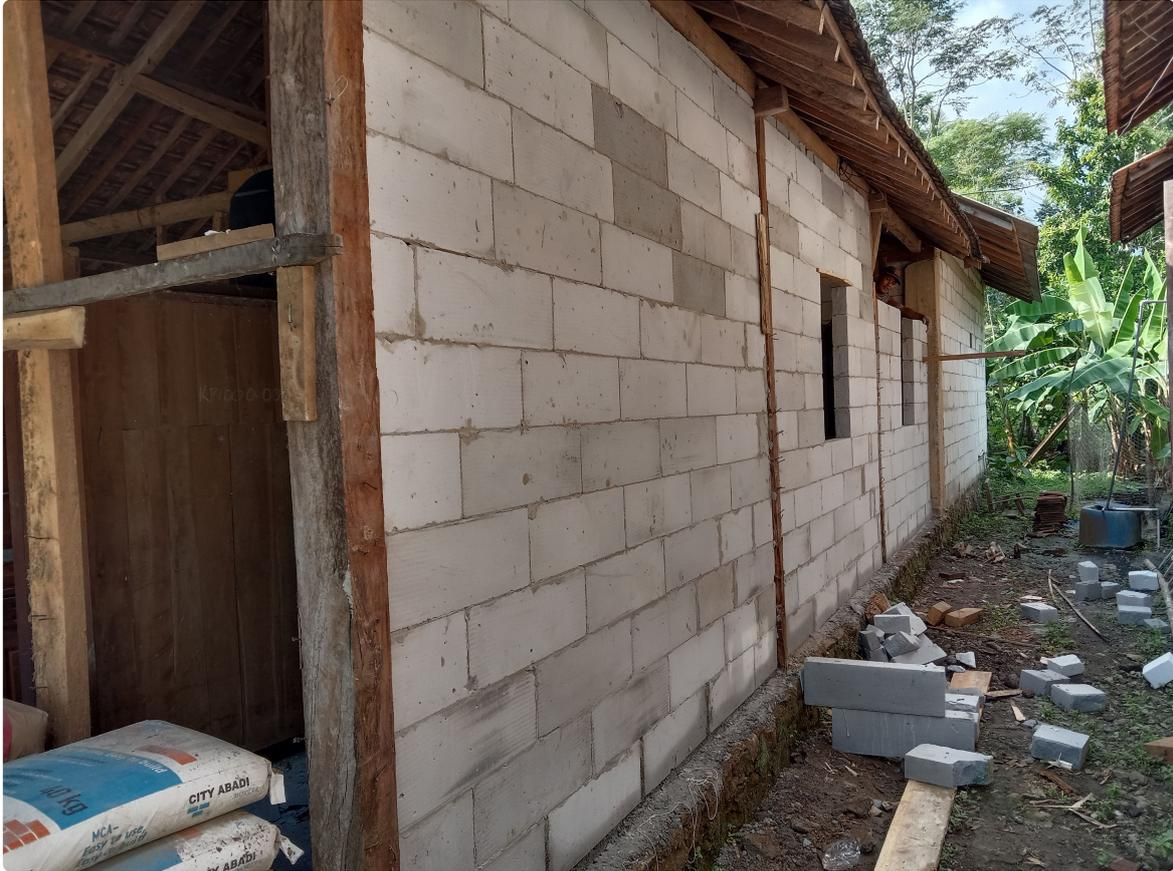
Luas bangunan rumah Fitriah yang dibangun 7 kali 6 meter. Akan dibangun menggunakan konstruksi bangunan bata putih untuk bagian tembok dinding dan dinding kamar, lantai cor.
